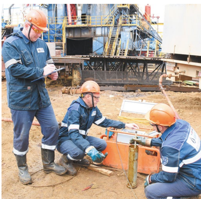
Буровики 7-го разряда Виталий Еськов, Евгений Гусев Бригады КРС и помощник буровика 5-го разряда ООО «БНГРЭ» Яков Макаров выполняют ремонтные работы
