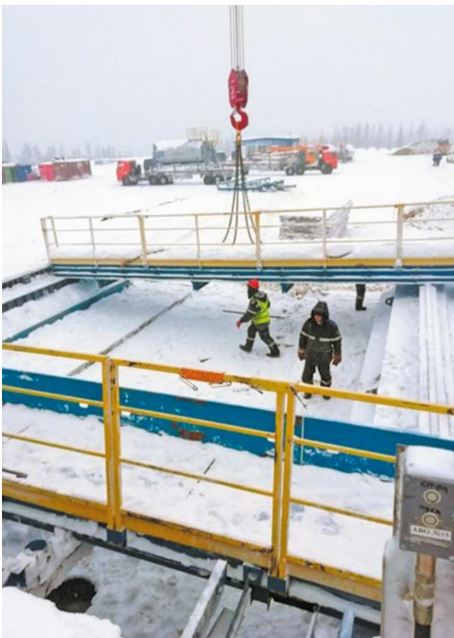
Монтаж переходных площадок КТУ на КП-21
