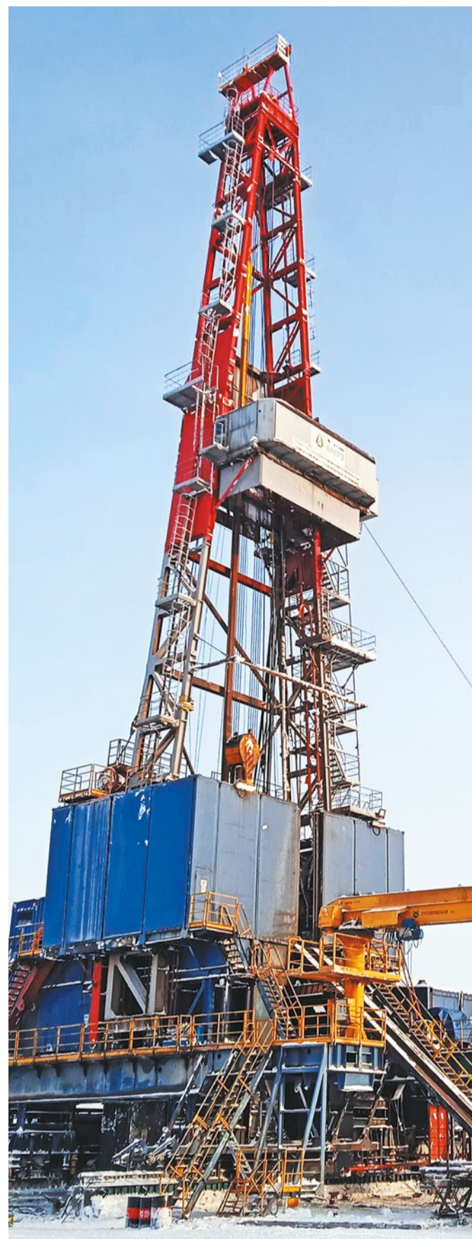
Буровая установка на КП-52 ООО «БНГРЭ»
